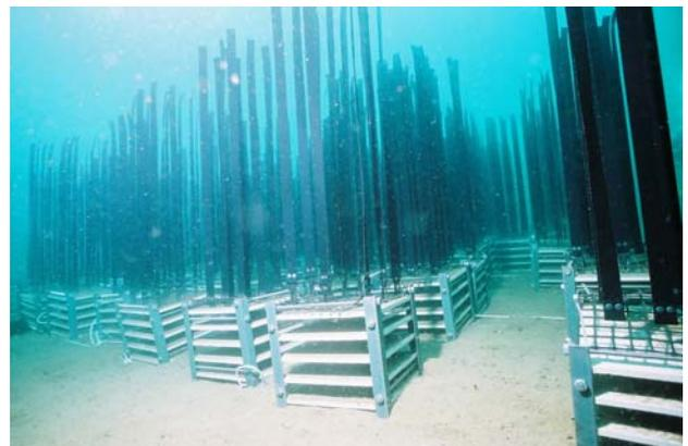
写真-1 炭素高配合ポリエチレン発泡体 (PE) の設置状況 (Mar. 25, 2002)
